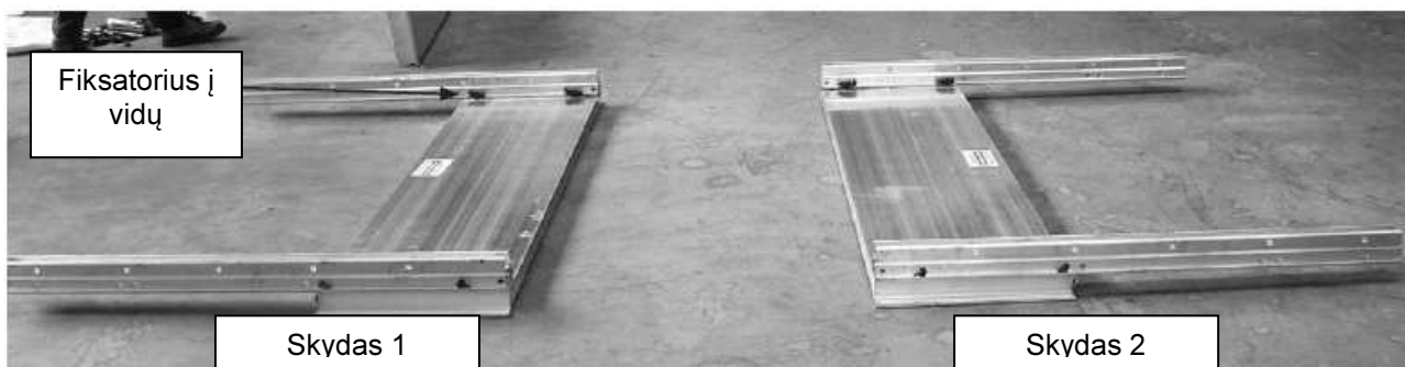
15 pav. Išramstymo skydų montavimas
