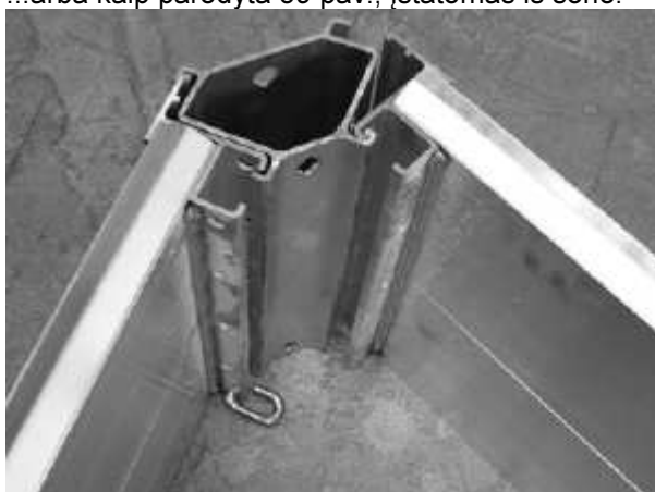
39 pav. Antro skydo montavimas – iš šono
