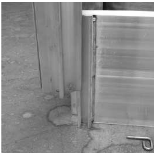
35 pav. Šachtos kampo profilio įstatymas
