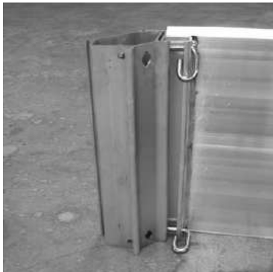
36 pav. Šachtos kampo tvirtinimas
