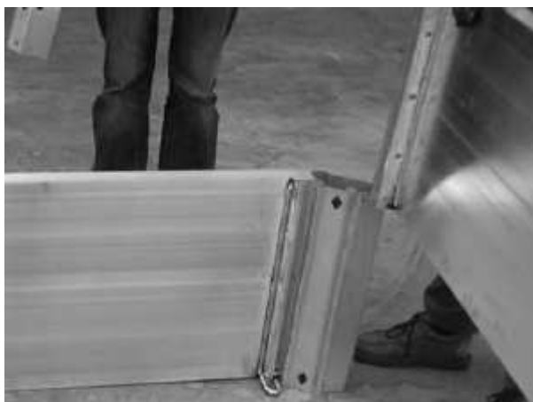
38 pav. Antro skydo montavimas – iš viršaus
